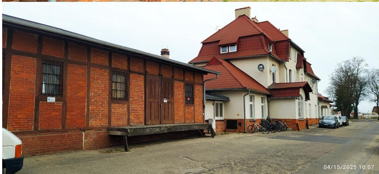
Budynek dworca PKP
