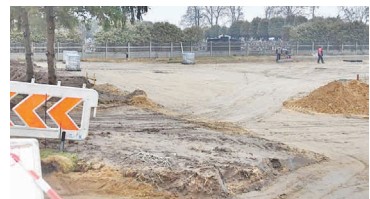
Trwają prace przy budowie parkingu.
