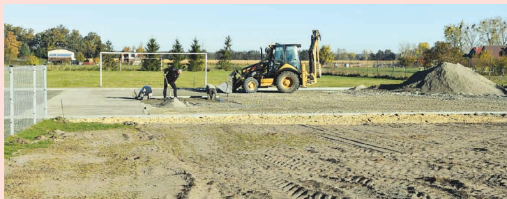
Prace przy budowie boiska w Uciechowie przebiegają zgodnie z założonym harmonogramem.
