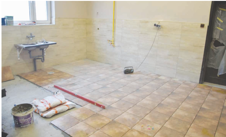
Zakres prac w pomieszczeniach kuchni oraz zmywalni w Świecy II jest szeroki.
